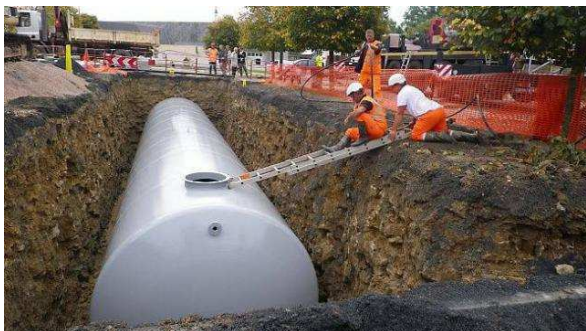
Réserve métallique enterrée
